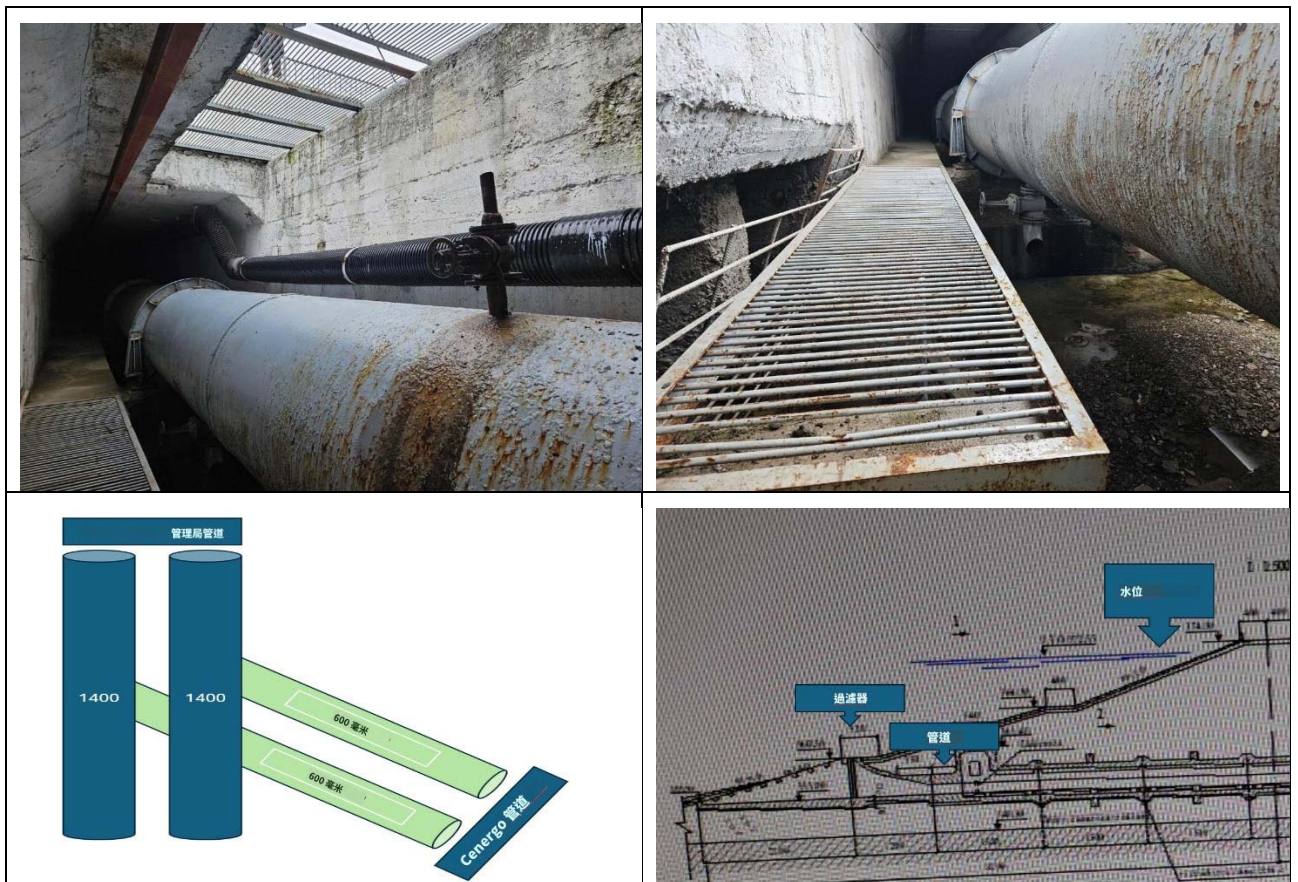
圖6：現有系統的供水管線設計
